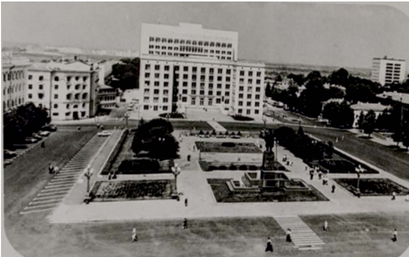
Abb. 4: Fotografie des Gebäudes des regionalen Komitees der KPdSU in Kasan, im Hintergrund der zusätzliche Plattenbau. Erstellt durch Kirill Alenbakh im Rahmen des Ausstellungsprojektes 'Proekt Staraja Kasan', vom Autor abfotografiert 2020 in Kasan.
