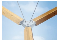
In der Stimmsele der Brettschichtholzstäbe wurden jeweils vier Stahlrohrhülsen eingeklebt und mittels Bolzen an den Knotenblechen angeschlossen. Der überdimensionale „Fußball“ aus Holzstäben wurde 2006 auf dem Firmengelände der Fa. Haas aufgestellt.
