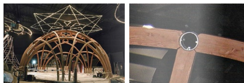
Die Kuppel in Aichi (Japan) setzt sich aus gebogenen Brettschichtholzträgern mit zwei unterschiedlichen Radien zusammen. Die biegesteifen Knotenpunkte werden über eingeklebte Gewindestangen hergestellt, Fa. Burgbacher, 2005.
