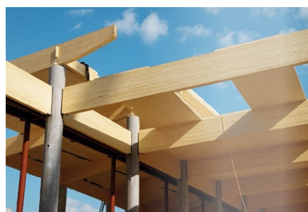
Brettspernholzplatten als Dachelemente des Einkaufszentrums G3 in Gerasdorf, Österreich. Entwurf: ATP, Architekten und Ingenieure. Ihre großen Vorteile gegenüber anderen Holzwerkstoffen mit parallel Faserverlauf sind die weitgehende Bruchfreiheit und ihre gleichmäßig geringe Schwindung in beiden Plattenebenen.
