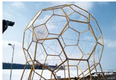
In der Stimmsele der Brettschichtholzstäbe wurden jeweils vier Stahlrohrhülsen eingeklebt und mittels Bolzen an den Knotenblechen angeschlossen. Der überdimensionale „Fußball“ aus Holzstäben wurde 2006 auf dem Firmengelände der Fa. Haas aufgestellt.
