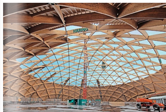
Die 120 m weit spannende Holzkuppel der Seitzlagerhalle in Rheinliden (Fa. Häring, 2013) beweist die Leistungsfähigkeit moderner Ingenieurkonstruktionen aus Holz. Die kurzen BSH-Stäbe der Schale wurden in den Knotenpunkten über eingeklebte Stahlbauteile miteinander verbunden.
