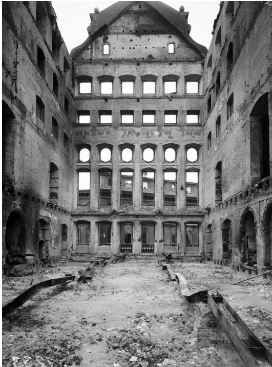
Abb. 16: Zerstörtes Rathaus (1944). Gegenüber ist die Ruine des städtischen Verwaltungsgebäudes 1 zu erkennen
