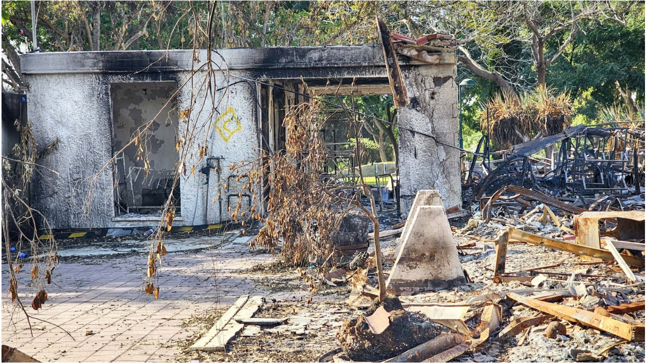
Schäden an einem Kibbutz in Israel verursacht durch Hamas am 7.10.2023
