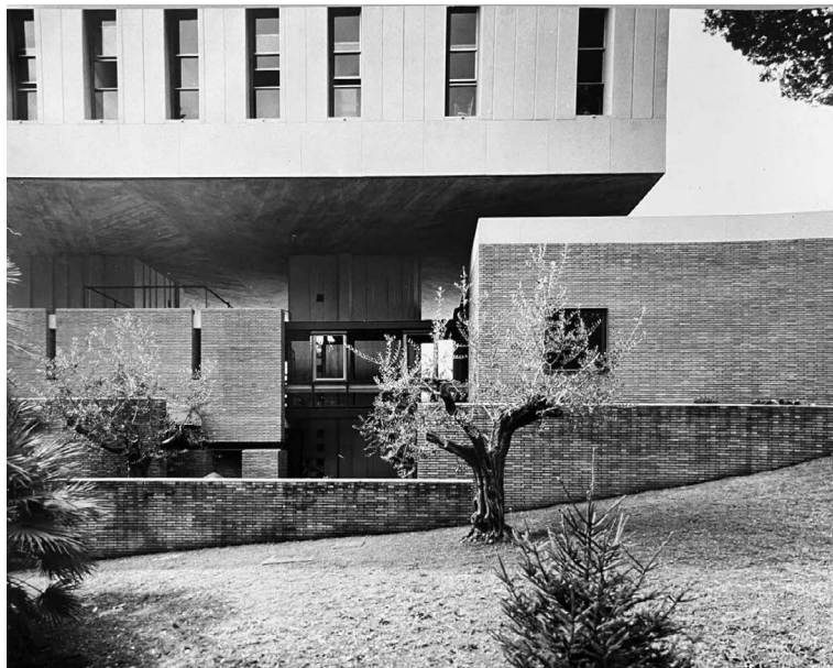
Fig. 8: Studio Passarelli, Curia Generalizia suore di Maria Vergine Immacolata, corpo basamentale, pilone centrale e corpo residenziale.
