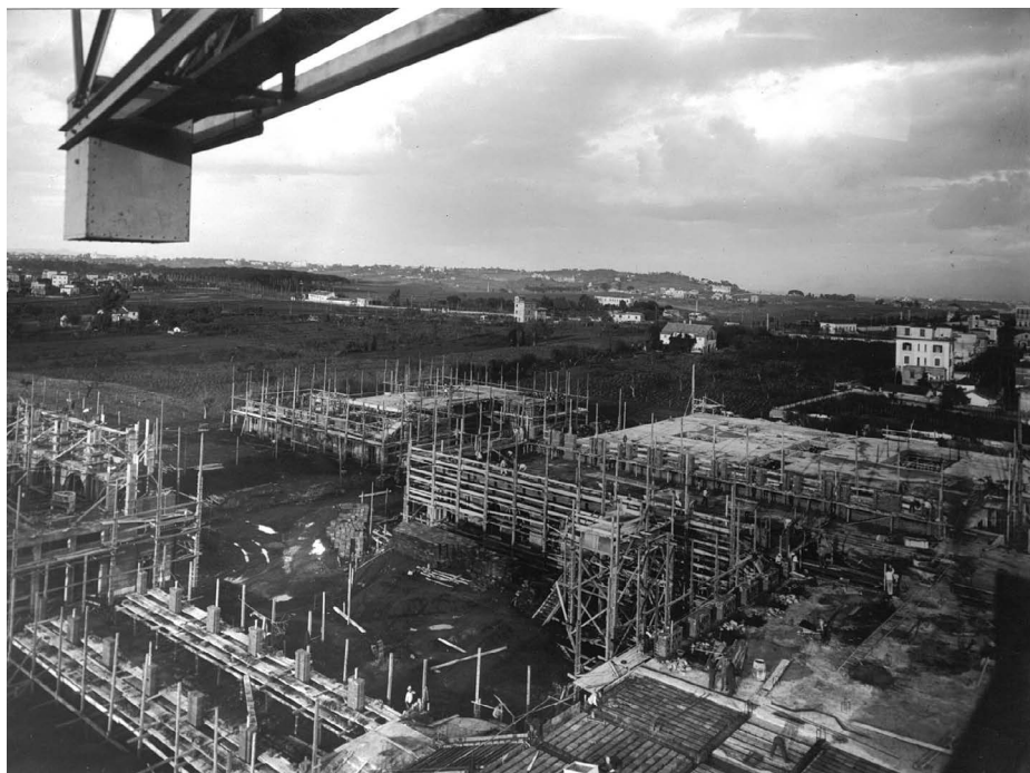
Fig. 5: Fratelli delle Scuole Cristiane, Cantiere Curia Generalizia in via Aurelia a Roma.
