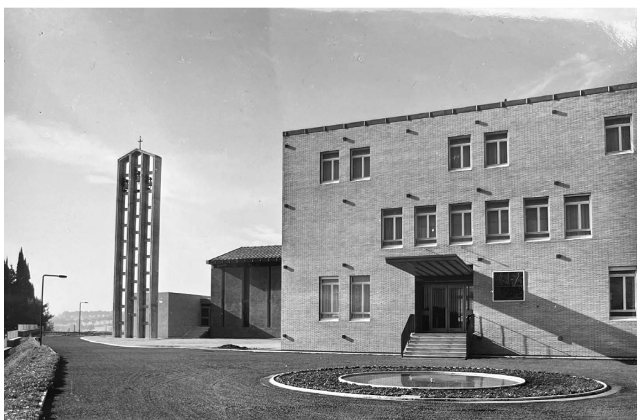
Fig. 7: Studio Passarelli, Curia Generalizia suore francescane della Penitenza e Carità Cristiane, ingresso curia e particolare elementi in prospetto.
