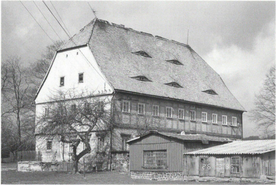
7. Eibau, Faktorenhof, Wohnhaus, Südostansicht, Zustand vor der Sanierung (1995)
