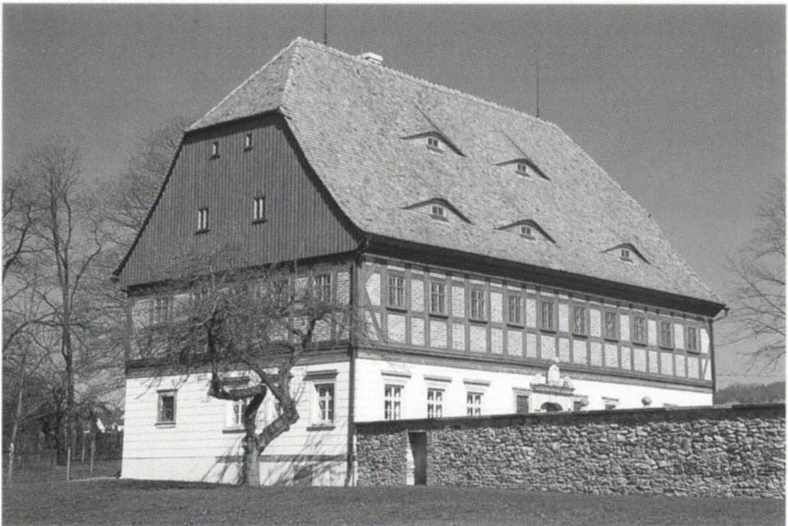
8. Eibau, Faktorenhof, Wohnhaus, Südostansicht, Zustand nach der Sanierung (2002)
