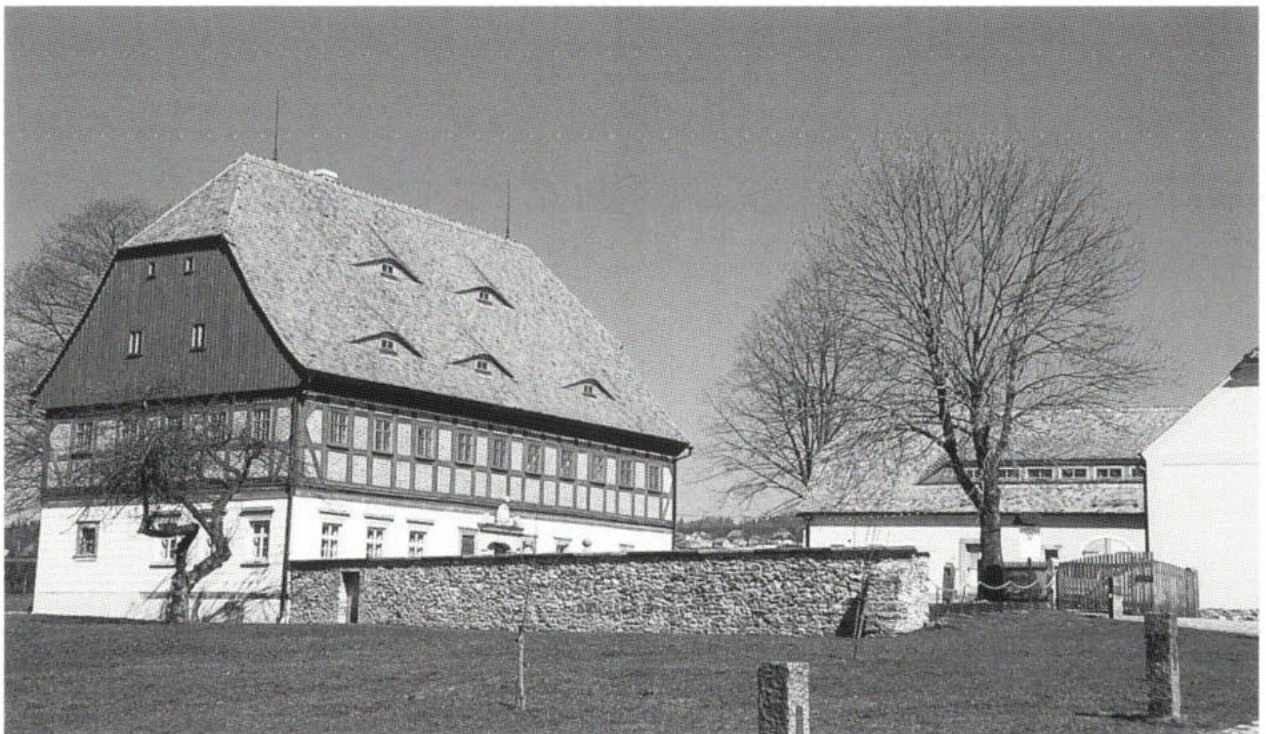
1. Eibau, Faktorenhof, Gesamtansicht von Süden, Zustand nach der Sanierung (2002)
