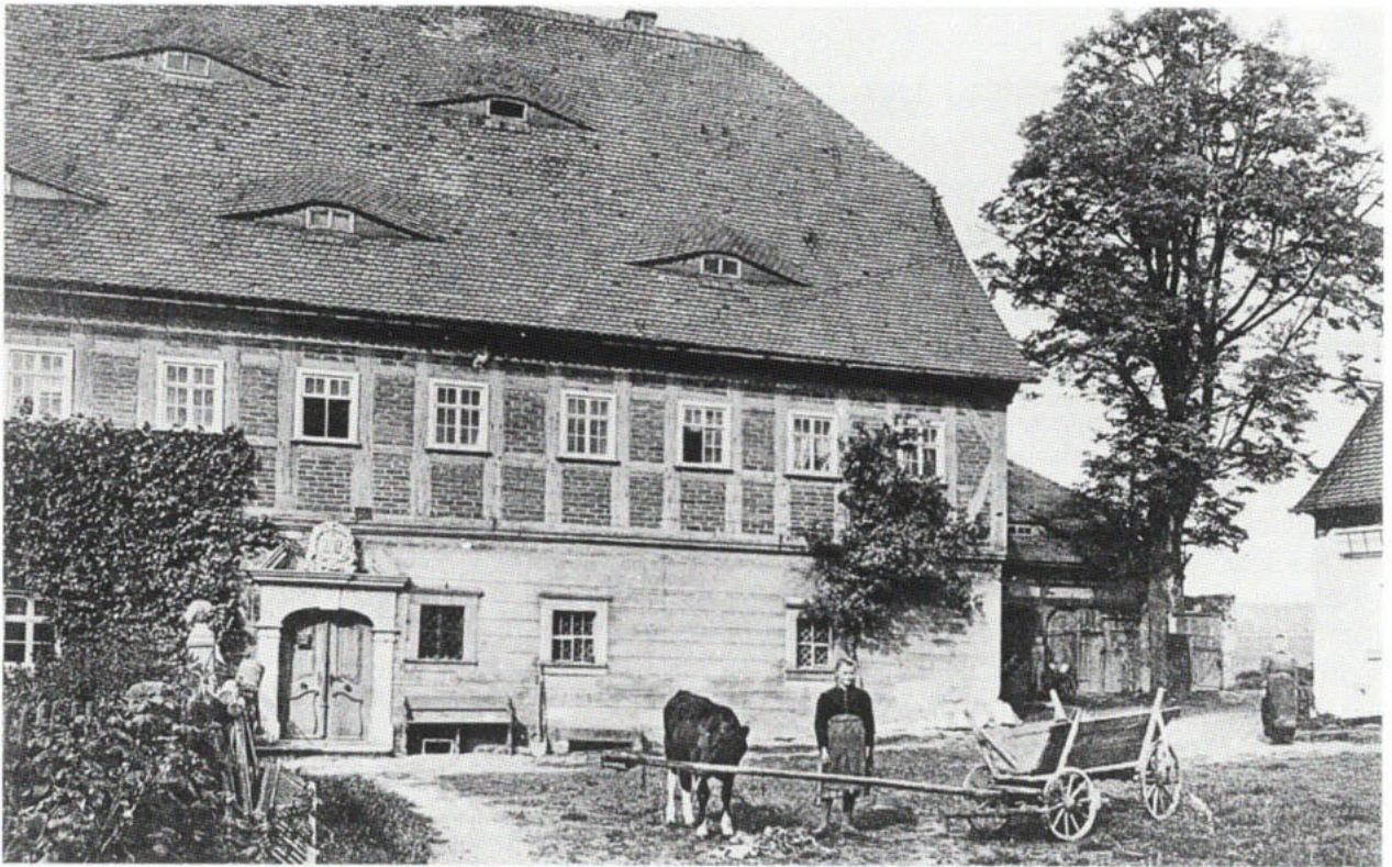
2. Eibau, Faktorenhof, Wohnhaus, Ostansicht, Zustand um 1910
