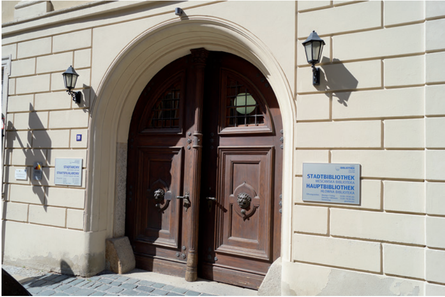
Abb. 1: Das Eingangportal der Stadtbibliothek Bautzen.
