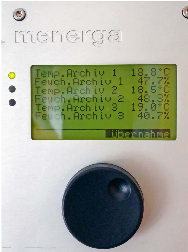
Abb. 3: Steuerung der Belüftungsanlage (Foto: Maria Löffler)
