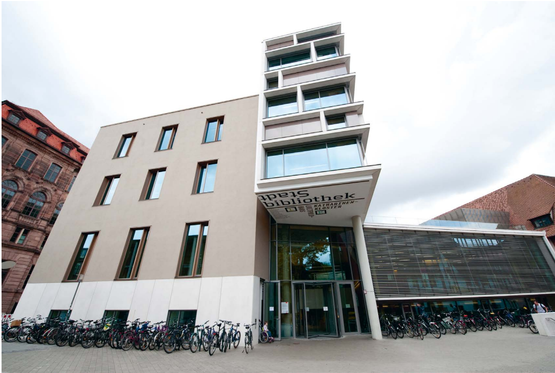
Abb. 3: Bei einer von 2009 bis 2012 durchgeführten Sanierung ist das Luitpoldhaus auf die ursprüngliche Traufhöhe von 1911 aufgestockt und um einen Verbindungsbau zum anliegenden Katharinenkloster erweitert worden (Foto: Jutta Missbach)
