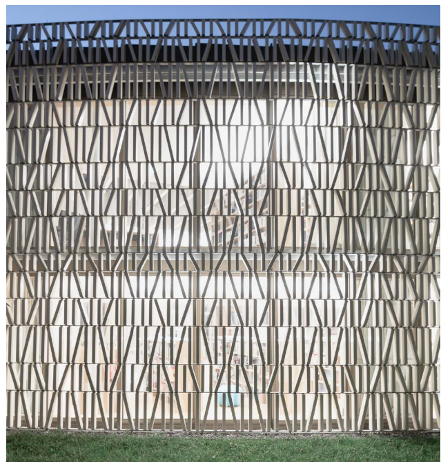
Abb. 5: Glasierte Keramikelemente dienen als feststehender Sonnenschutz (Foto: Aldo Amoretti)
