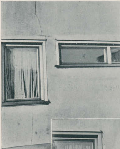
Groteske Fenster- mache. — Setzrisse und Sprünge vom Sockel bis zur Dach- brüstung.
