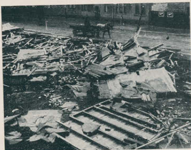
Typisches Flachdach-Zerstörungsbild.
