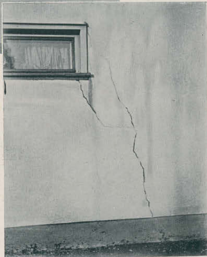
Groteske Fenster- mache. — Setzrisse und Sprünge vom Sockel bis zur Dach- brüstung.
