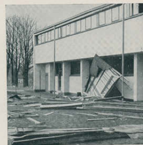
Das abgeflogene Dach der Budge-Stiftung (80 qm) in Frankfurt a. Main. Aufn. 1930.
