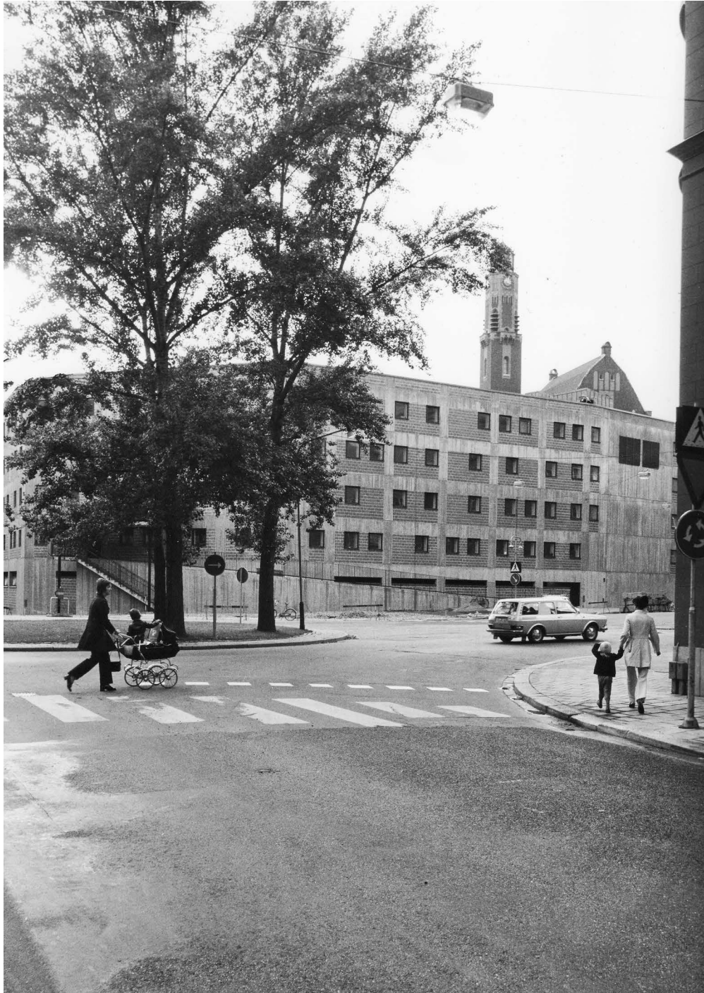
4–5 Main façade towards the street in the upscale Östermalm neighbourhood | Die straßenseitige Hauptfassade im eleganten Stadtviertel Östermalm, 1970 © Sten Vilson; the ivy intended to cover the raw concrete never really took hold | der Efeu, der den Sichtbeton überwuchern sollte, fasste nie wirklich Fuß, 2015 © Tove Freij
