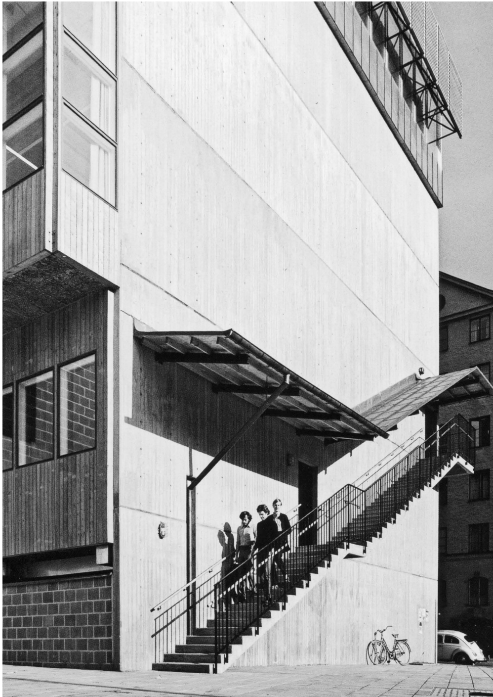
12–13 Students on the staircase of the south gable entrance | Studierende auf der überdachten Treppe des Südeingangs, 1970 © Sten Vilson; by 2015 the space under the stairs is routinely used as shelter by Stockholm's homeless | 2015 wurde der Raum unter der Treppe regelmäßig von Stockholmer Obdachlosen genutzt, 2015 © Tove Freij
