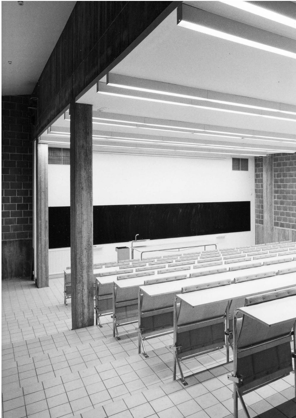
16–17 Auditorium with customized steel tube folding seats | Auditorium mit eigens gefertigter Stahlrohrklappbestuhlung, 1970 © Sten Vilson; by 2015, intact but with exposed plywood after the upholstery was worn out by thousands of lecture hours | 2015 noch immer intakt, aber mit sichtbarem Sperrholz, nachdem sich die Polsterung in Tausenden Vorlesungsstunden aufgelöst hat, 2015 © Tove Freij
