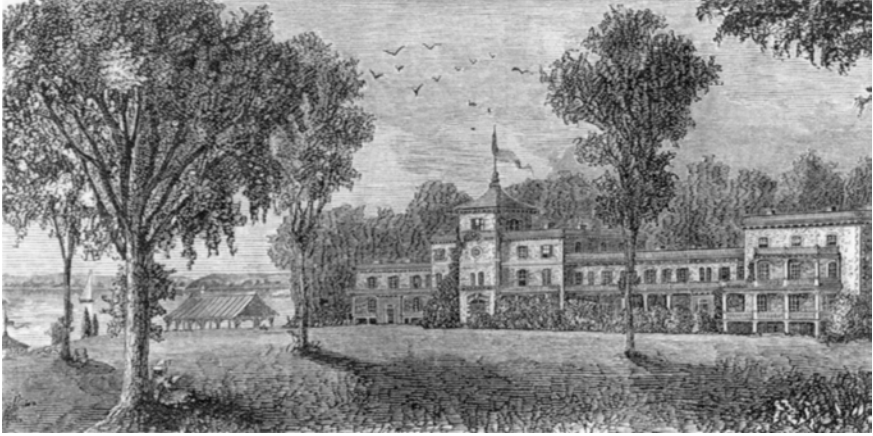
Abb. 27: Gebäude der Raritan Bay Union
