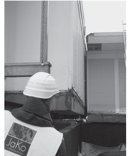
Abb. 19: Millimeterarbeit; die beiden Teile von L 141 mussten passgenau wieder zusammengefügt werden, 2022.
