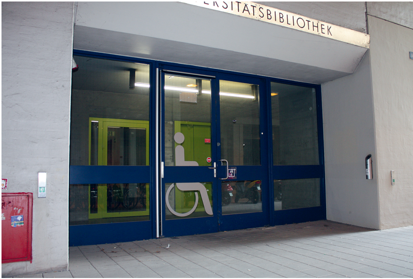
Abb. 3: Eingangsbereich der Universitätsbibliothek Regensburg mit gut sichtbarer, farblicher Kennzeichnung sowie elektronischem Türöffner. (Foto: Harald Kloth).
