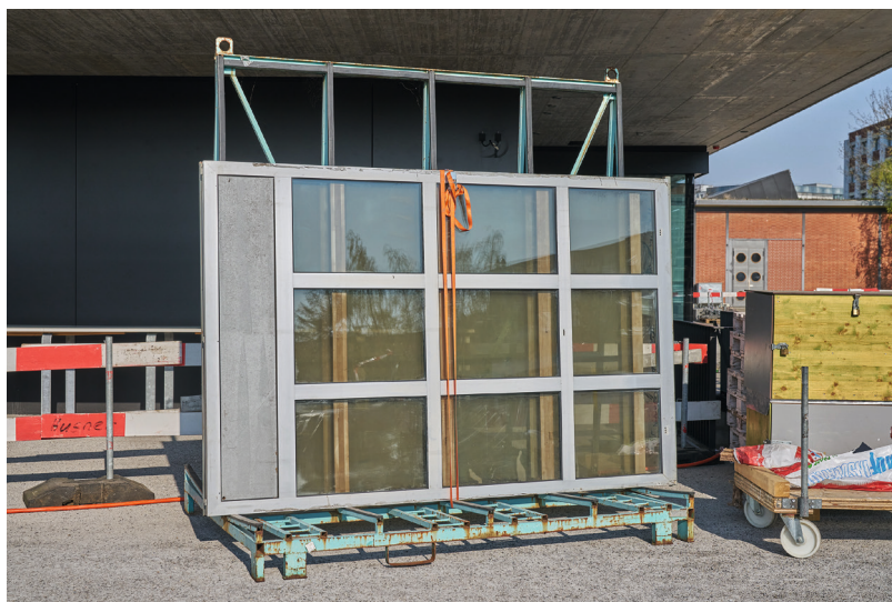
8 Unit Sprint, NEST Dübendorf, 2021, baubüro in situ ag, Basel, Wiederver- wendung und Ertüchtigung bestehender Fenster und ihrer Gläser.
