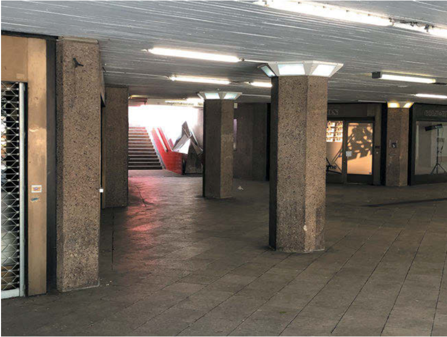
Abb. 3.2.2: Unterführung im westlichen Teil des Ebertplatzes, Köln (April 2021).
