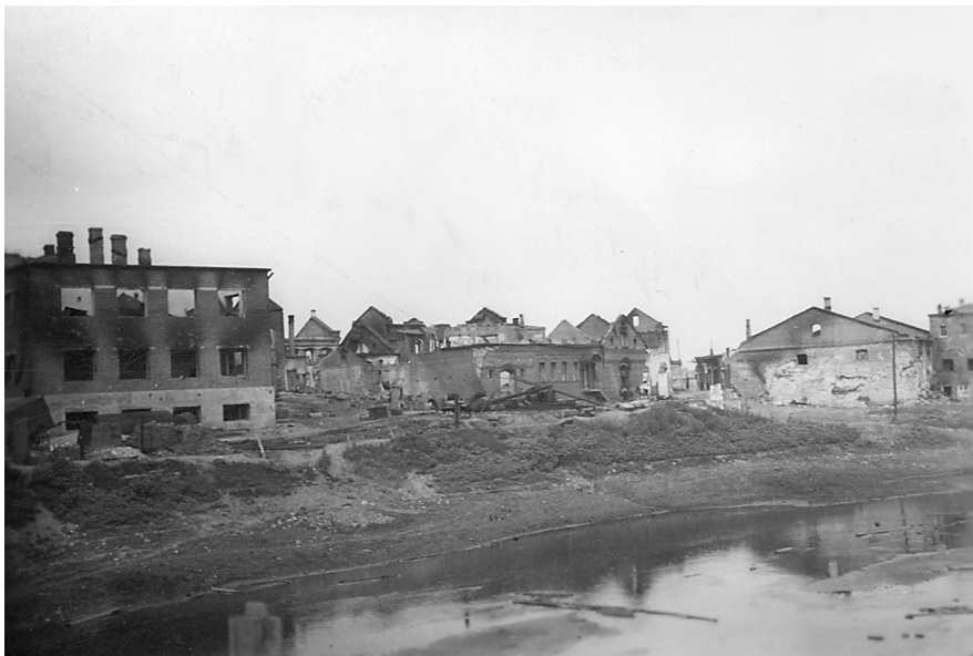
Abb. 1: Großflächige Zerstörungen in Orscha, Blick auf das Flussufer. Foto: Anonym, vermutlich 1941. Quelle: Privatbesitz.
