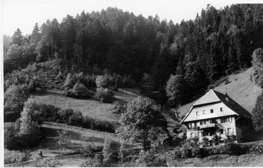
Abb. 7: Der 1921-1923 erbaute Waldvogelhof in Wildgutach (Aufnahme aus den 1930er Jahren)
