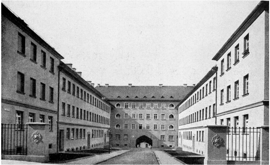
Abb. 61, 62: Konrad Sorg, Wohnsiedlung St. Johannis, Nürnberg, 1925–1927
