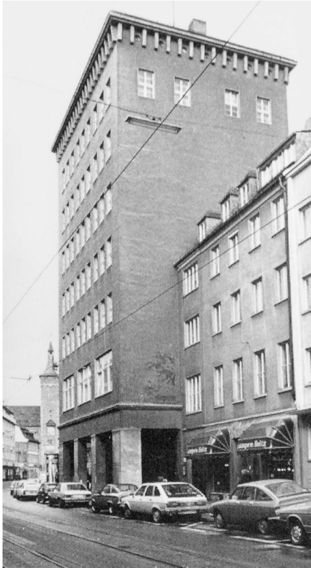
Abb. 95: Franz Kleinsteuber, Hochhaus Augustiner- straße, Würzburg
