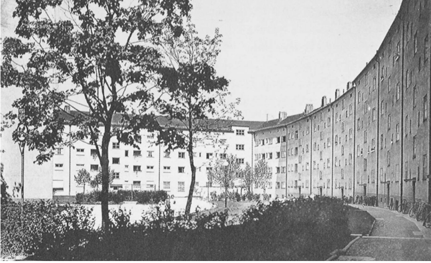
Abb. 58: Siedlung Neu-Ramersdorf, Innenhof, München
