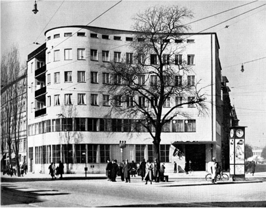
Abb. 84: Walther Schmidt/Franz Holzhammer, Postamt am Goetheplatz („Goethepost“), München, 1931–1933
