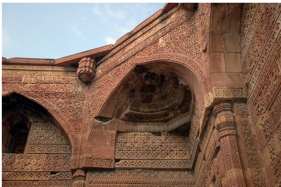
Abb. 6: Delhi, Qutb-Komplex, Detail einer Ecklösung und eines Konsolensteins im Grabbau, um 1230
