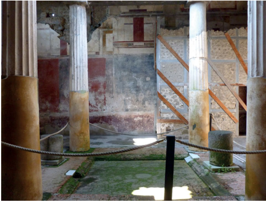
Abb. 39: Atrium, Blick von Osten auf die Westwand mit subscalare (mit Genehmigung des Ministero dei Beni e delle Attività Culturali e del Turismo – Soprintendenza Pompei. Reproduktion und Vervielfältigung untersagt).
