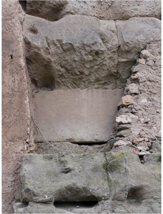
Abb. 8 | Rom, Forum Romanum, Tempel des Antoninus Pius und der Faustina, westliche Längsseite, Abarbeitung für ein Kopfprofil. Foto H. Behrens, DAI-Rom dig. 2010.3385.
