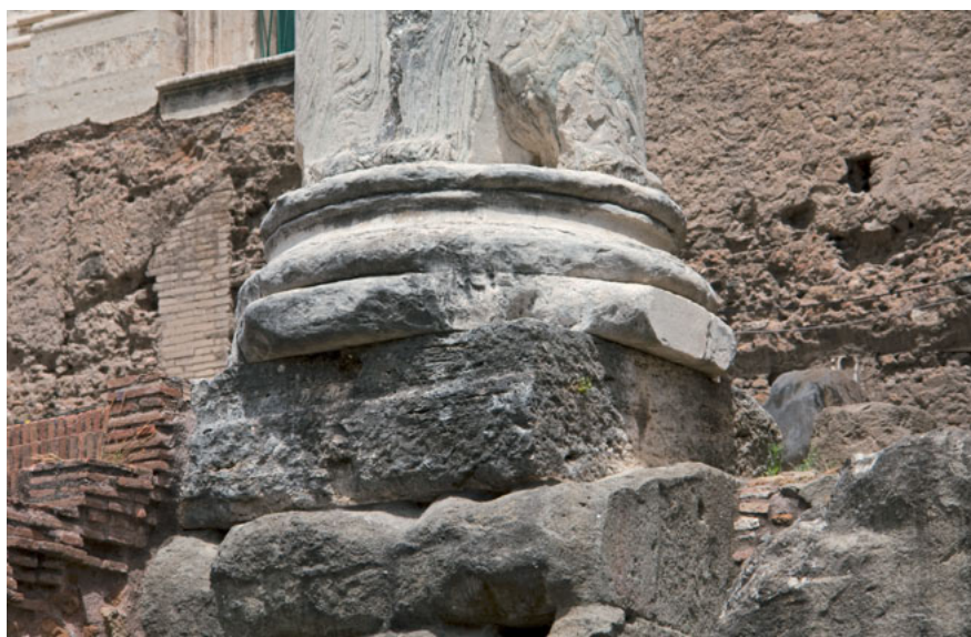
Abb. 7 | Rom, Forum Romanum, Tempel des Antoninus Pius und der Faustina, Pronaos, Plinthe aus Travertin mit darüber liegenden Plinthe der marmornen Säulenstellung aus antoninischer Zeit. Foto H. Behrens, DAI-Rom dig. 2008.2416.
