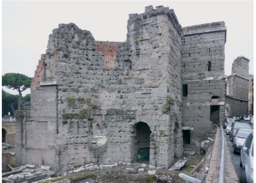
Abb. 11 | Rom, Augustusforum, Umfassungsmauer aus Tuffquadern. Foto H. Behrens, DAI-dig. 2010.3381.
