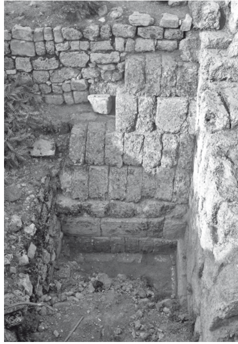
Abb. 2 a. b | Geböschter Mauerfuß im Altarhof des Jupiter-Heiligtums in Baalbek
