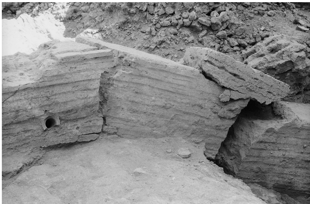
Abb. 7 | Zumindest teilweise könnte der Einsturz des Gebäudes vom Piazzale auf ein Erdbeben zurückgehen, das sich vielleicht um 500 n. Chr. ereignet hat; nach Süden.
