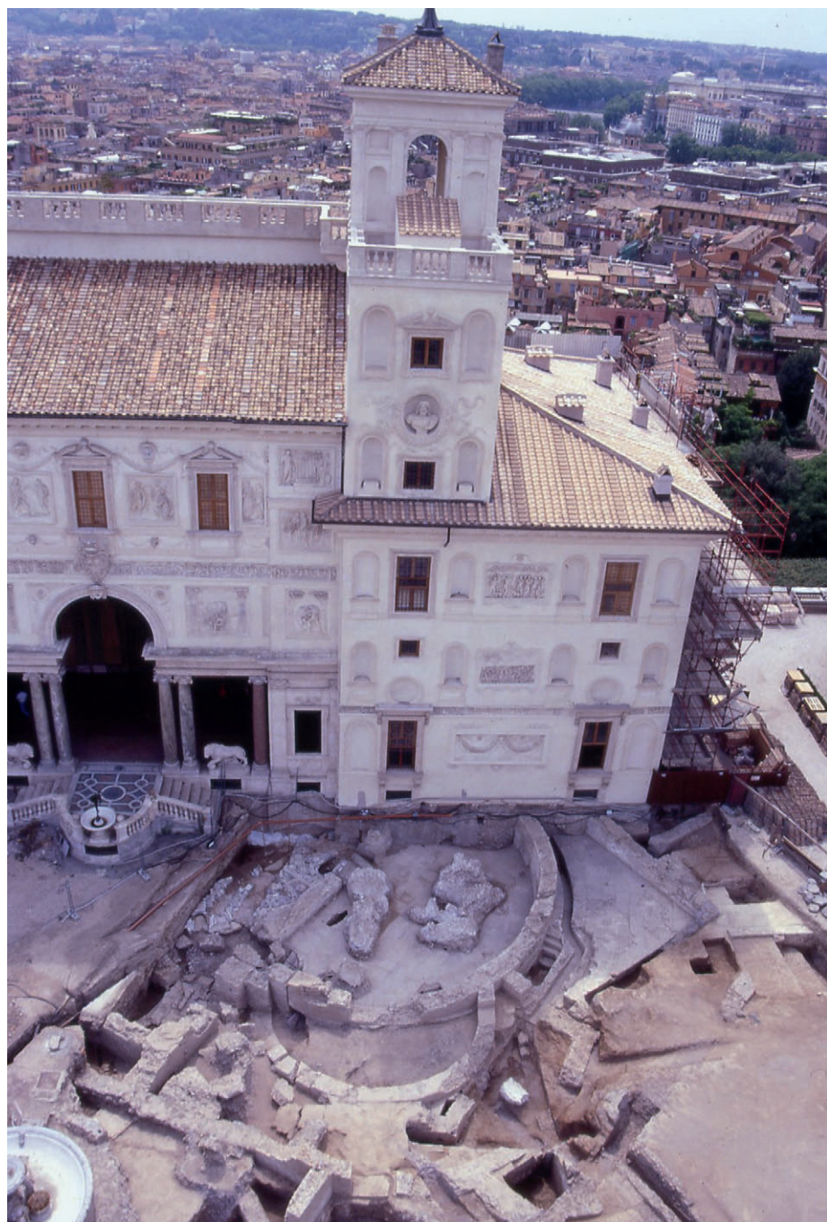
Taf. 4 | Gesamtansicht des in der ersten Hälfte des 5. Jh.s n. Chr. errichteten Gebäudes vom Piazzale der Villa Medici nach den Ausgrabungen 1999, nach Osten.
