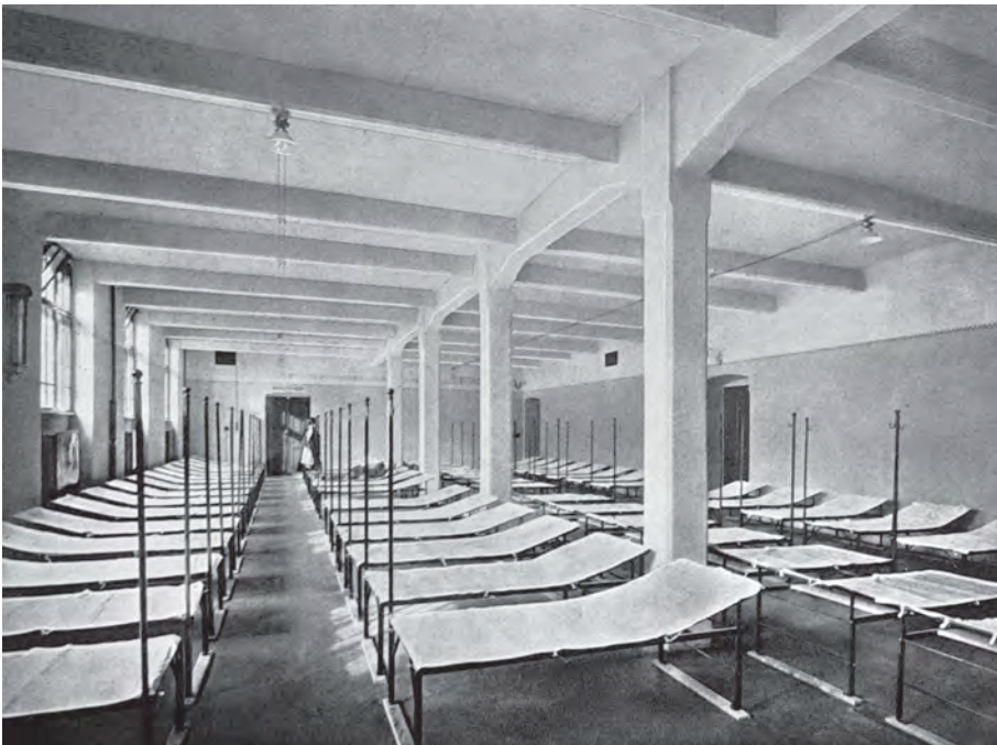
58 Schlafsaal im alten Asyl- und Werkhaus der Stadt Wien (aus: Magistratsabteilung X, Hg., Das Asyl- und Werkhaus der Stadt Wien, Wien 1913).
