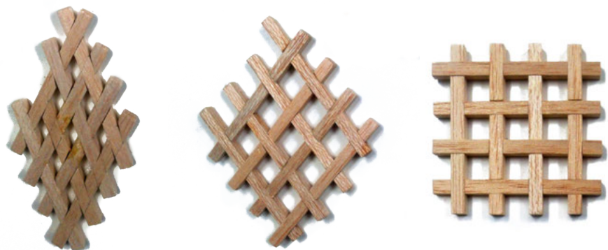
► Fig. 6 | Abb. 6: Jigoku grid / Chidori grid .
